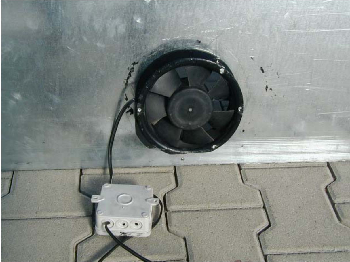
Fig: 27 shows a fan insert and rivet in fan plate
